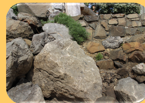
Figure 19 : Végétation des enrochements
